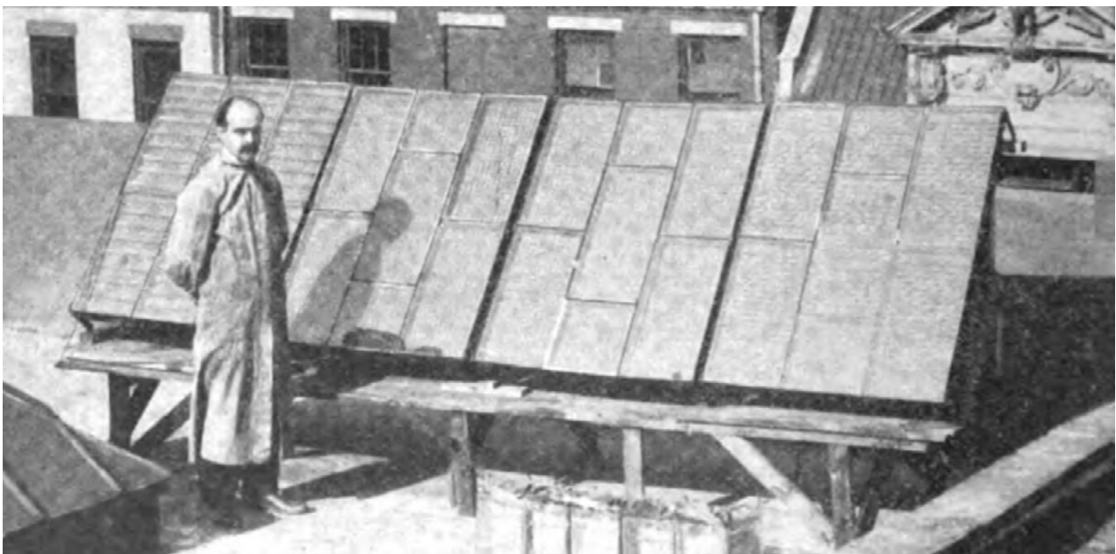
George Cove junto a su panel solar. Fuente: "Generación de electricidad por los rayos del sol", Electricidad Popular , Tomo 2, nº 12, 1910.
